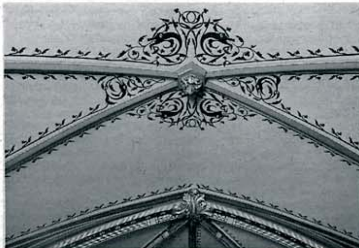
Vroeger zeer bewerkelijke motieven zoals rond rozetten konden in korte tijd vanuit een klein restant worden gereconstrueerd...
