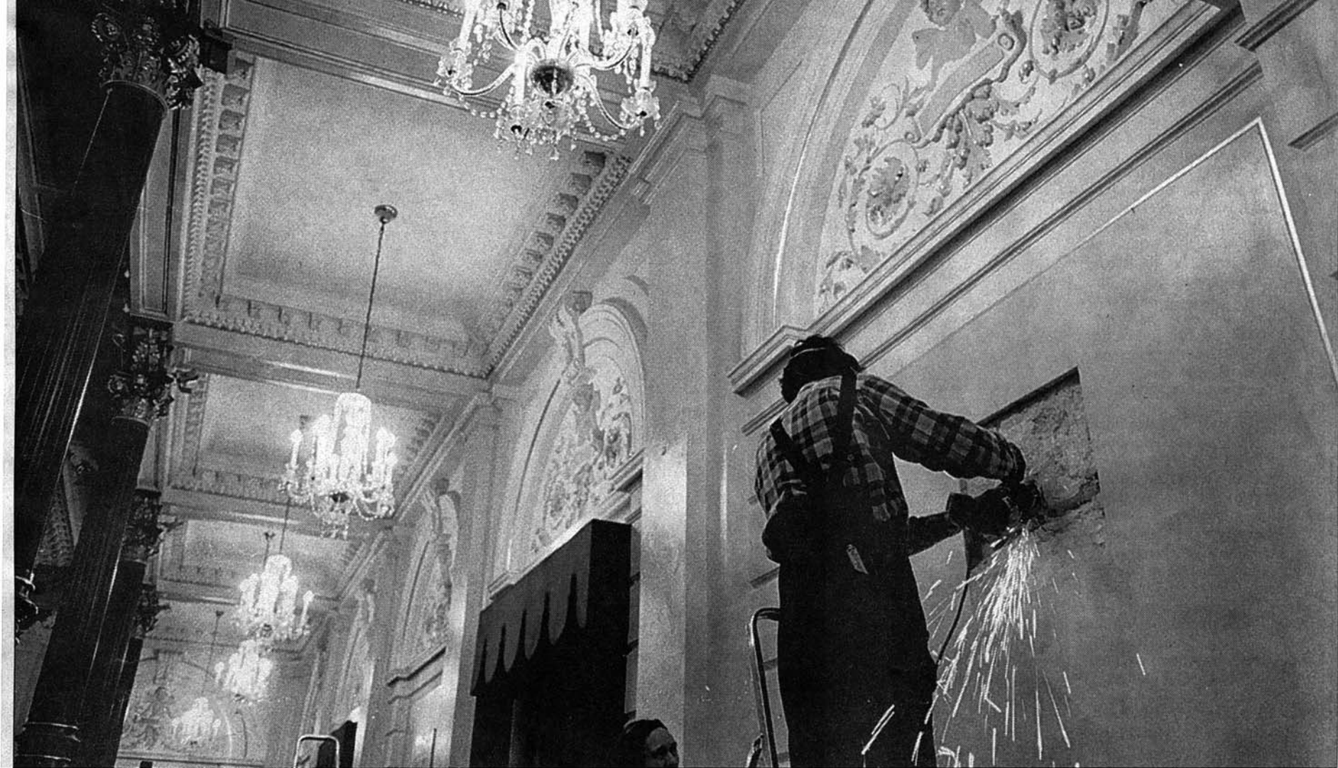
Een loodgieter verwijdert in de Grote Zaal een oude gasleiding op de plaats waar de Mahler-plaquette moet komen.
