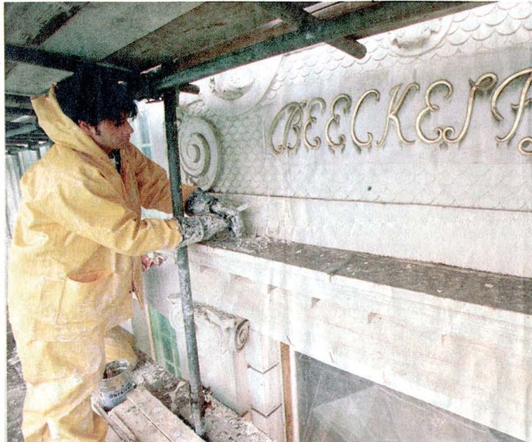
Bouwvakkers zijn nog druk bezig met het schoonmaken van de gevels van Beeckestijn. Al de oude, 'te witte' verf gaat er af.
