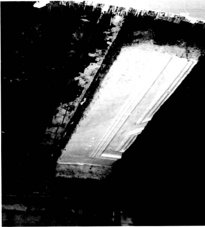
Afb. 8. Het gedeelte van het plafond in de aangrenzende ruimte, dat tevoorschijn is gekomen bij ontmanteling (foto E. Orsel)
