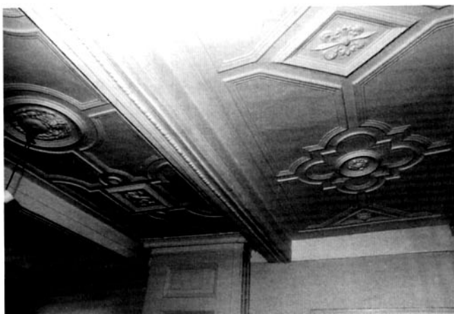
Afb. 1. Overzicht van het stucplafond, gezien in zuidelijke richting (herkomst: gemeente Leiden, fotoarchief bureau Monumenten en Archeologie)
