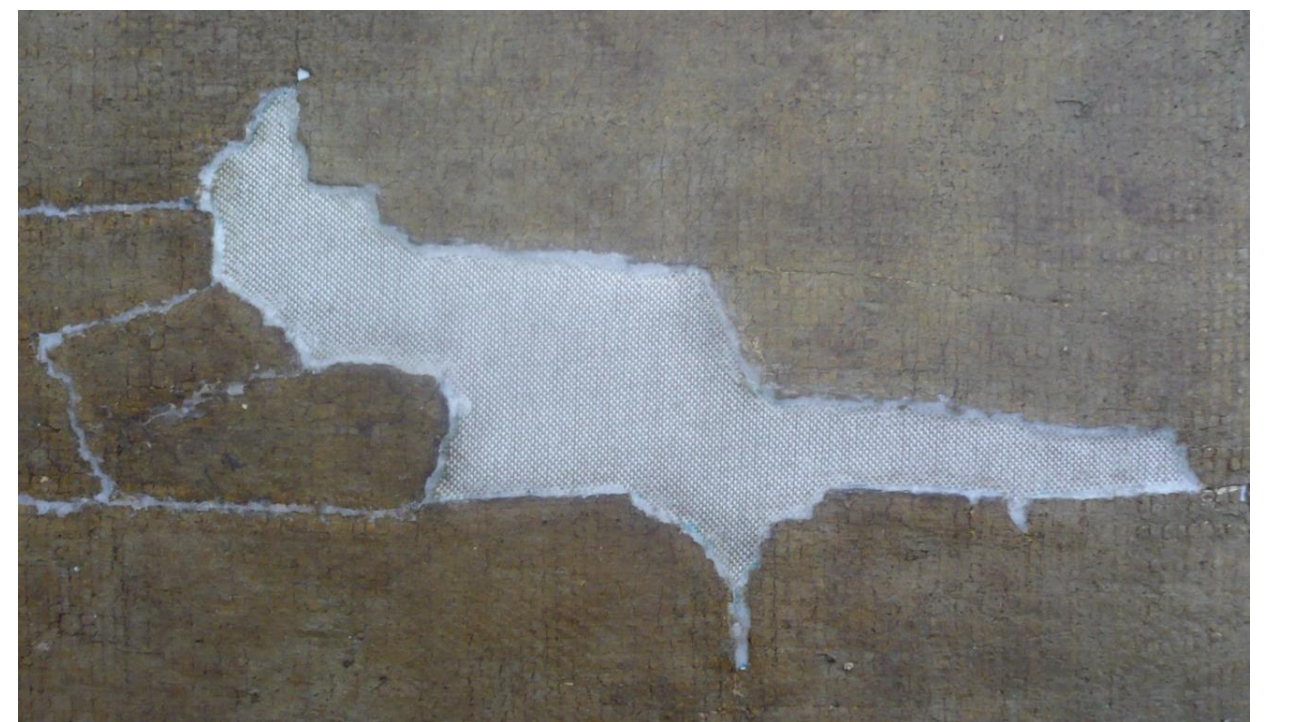
In grote gaten is een nieuw stuk polyesterdoek ingelegd.
